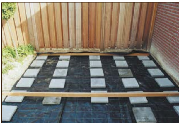
Abbildung: Verlegung von Unterkonstruktionsholz auf Waschbetonplatten
